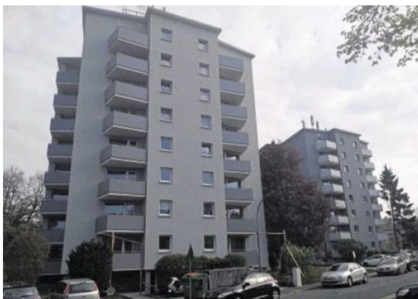
Um diese beiden Hochhäuser an der Pfistermeisterstraße 65 und 67 geht es. Hier wohnen mittlerweile 13 Flüchtlinge aus der Ukraine. Bild: Kosarew
