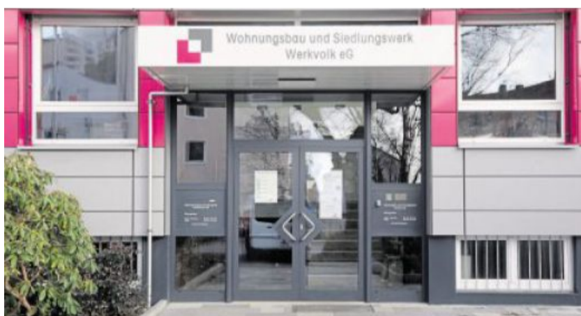
Das Wohnungsbau- und Siedlungswerk Werkvolk hat seinen Sitz in der Hans-Thoma-Straße, mitten im Milchhof-Viertel. Erfahrungsgemäß landen in diesem Bereich viele Bäume verbotenerweise an Container-Standorten. Bild: Steinbacher
